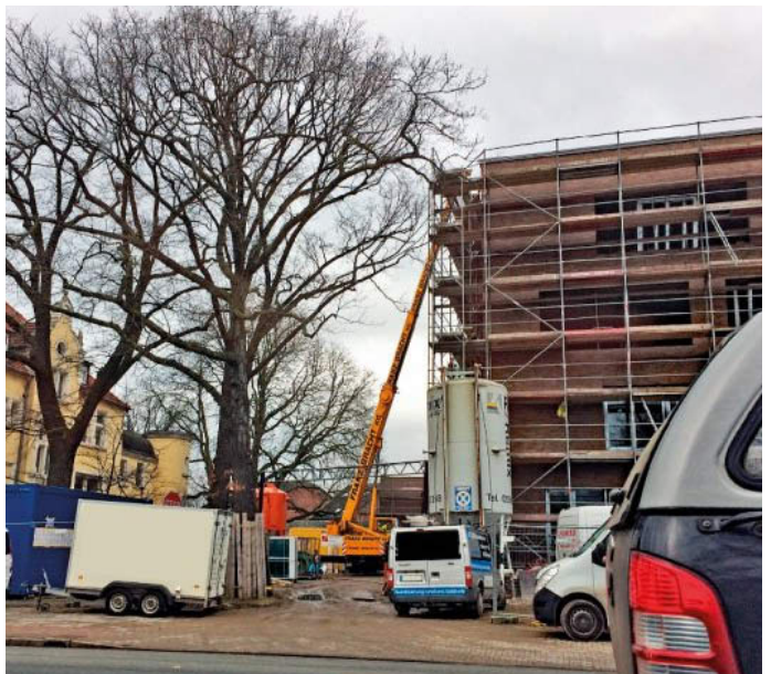
Die Baustellenzufahrt liegt im unmittelbaren Schutzbereich der Baumgruppe. Die Pfützen zeigen, wie der Verkehr den Boden verdichtet und so den Wurzelbereich geschädigt hat.
