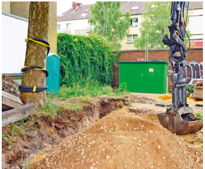
Auch bei dieser Baumaßnahme stand der Schutz des Baumes nicht im Vordergrund. Die Standsicherheit ist mit Blick auf die Wurzelverluste zweifelhaft. Fotos: Streckenbach/Dreß
