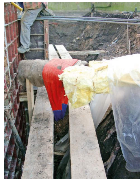
// Mit textilen Gurtbändern gut abgepolsterte Starkwurzel //
