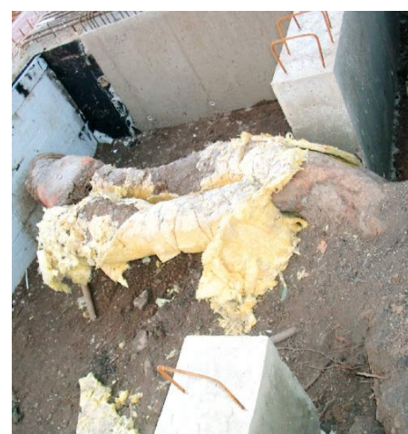
// Wurzelkeller mit Aussparungen für das Dickenwachstum der Wurzeln //
